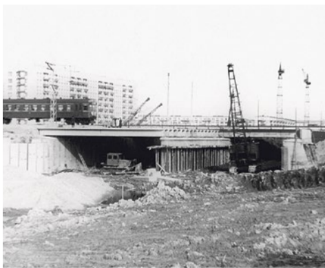
Строительство путепровода проспекта Славы, 1966 год
