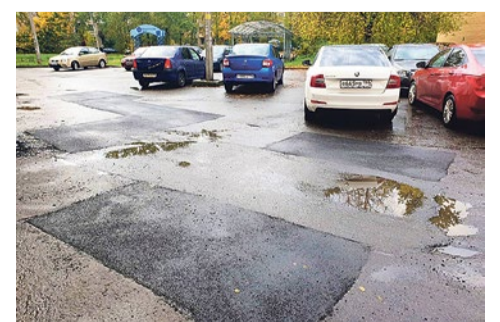
Ямочный ремонт на улице Турку, 32/1
